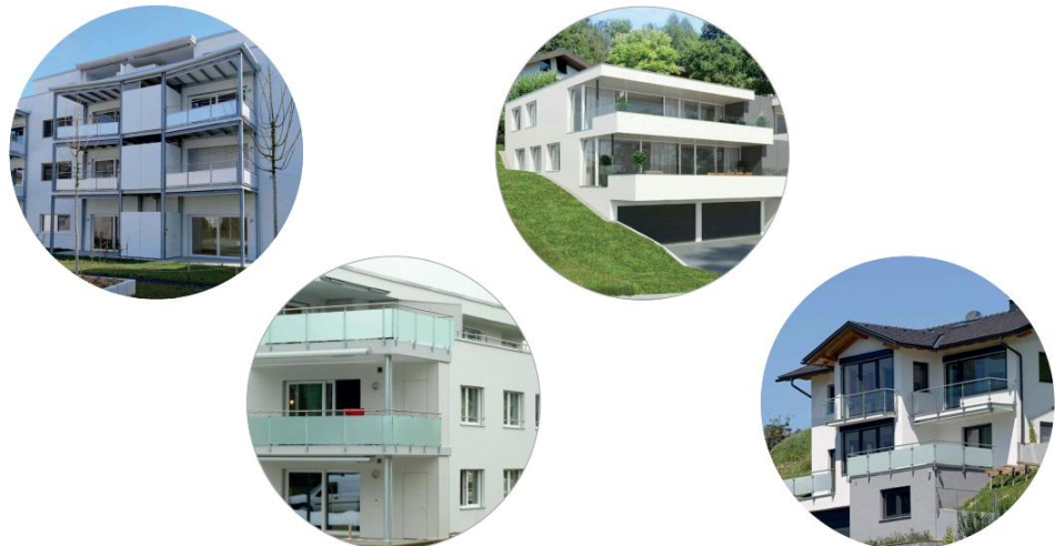
Abbildung 27: Auf den Einsatz von Glas für Loggien und Brüstungen ist zu verzichten
