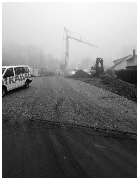
Erschliessung Unterschachen – die Bürgerstrasse im Bau
