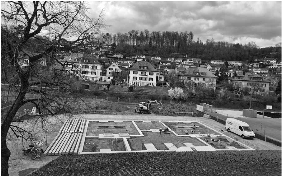
Das Fundament ist bereit für den Aufbau
