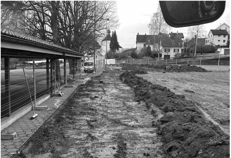
Die Arbeiten beginnen
