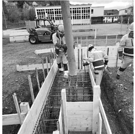
Arbeiten am Fundament
