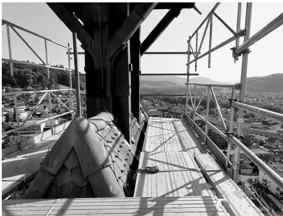
Gerüstaufbau reichte bis zum Dachreiter
