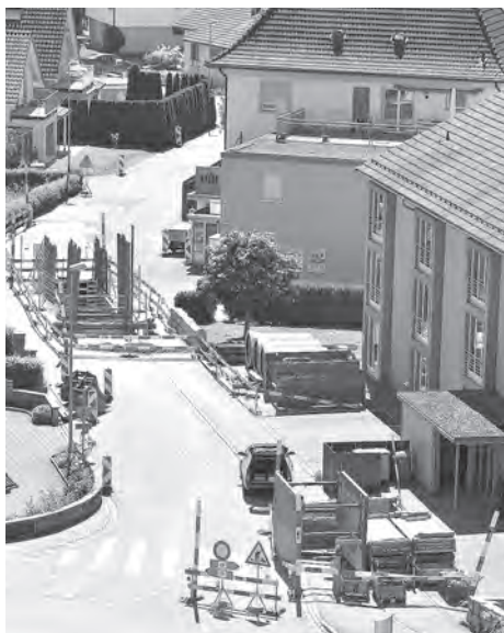
Kanalersatz an der Aarestrasse
